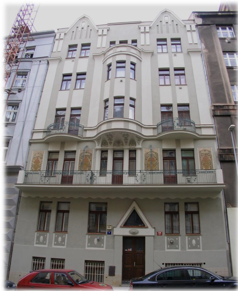
Vršovice Bulharská ulice
